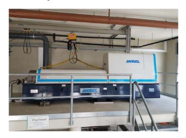
Cette dernière, en fonction depuis 2005 soit depuis une douzaine d'années, arrive en fin de cycle. Il est nécessaire de rénover dite installation par l'intermédiaire d'un remplacement complet des pièces d'usure à savoir : la vis, le bol et les paliers, c'est-à-dire les parties mobiles.
