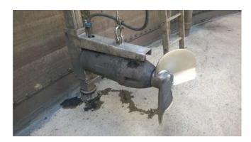
Au niveau technique, la mise en place de ce nouveau brasseur nécessitera l'installation d'une nouvelle potence et d'un escalier d'accès pour assurer son entretien.
